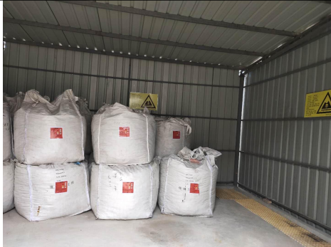
危废库地面硬化及包装标志
