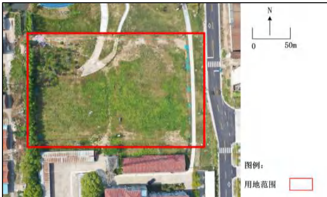
图 3.3-1 2022 年 5 月无人机航拍照片
