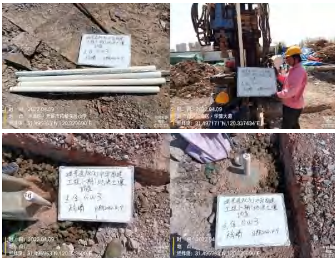
图 4.2-8 现场采样井建设
