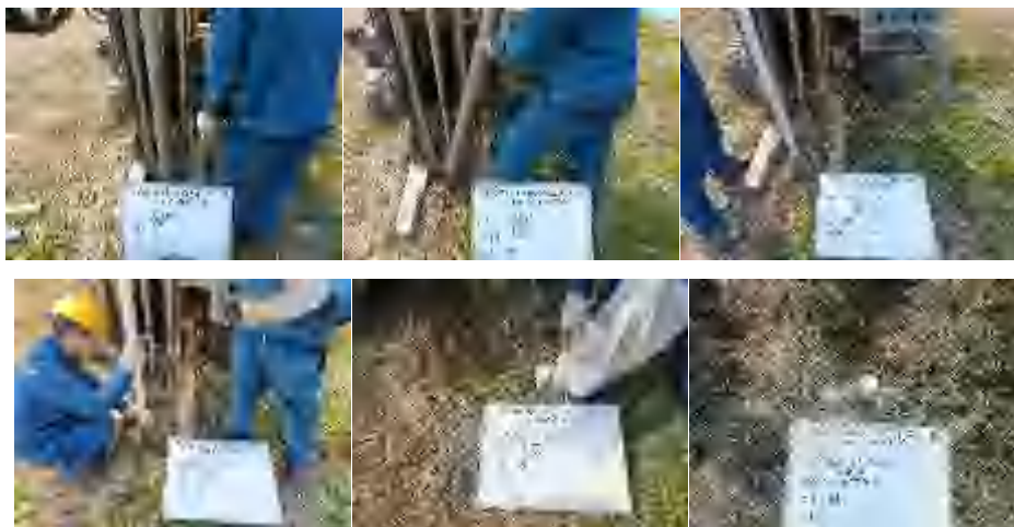
图 5.1-9 现场采样井建设
